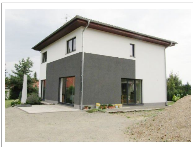
JZ a JV fasáda
