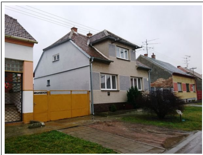
Pohled z ulice
