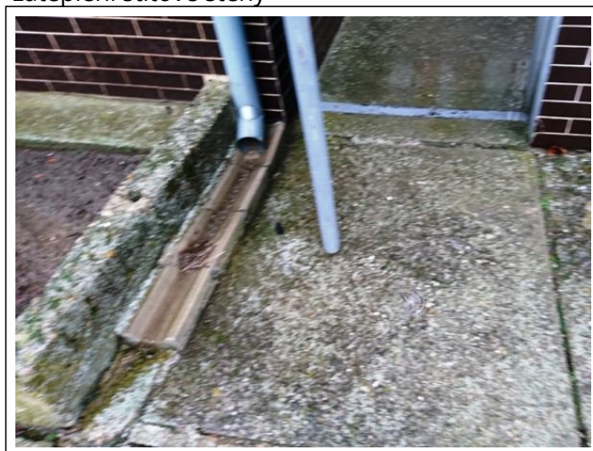
Likvidace dešťové vody - odtok po zpevněné ploše
